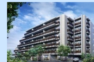
シェルゼ武蔵中原 総戸数48戸 2008年12月竣工
